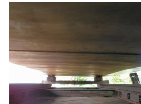
Het vlak is klaar en geveerd
